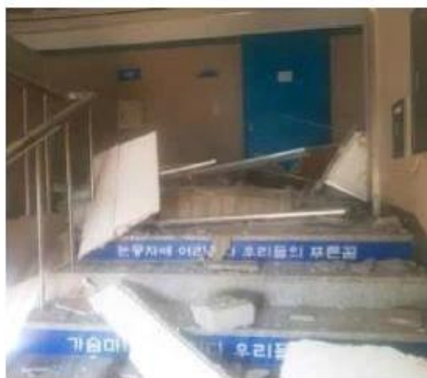
* 천장구조를 탈락에 의한 복도 및 계단실 피난경로 피해(2017. 포항)
