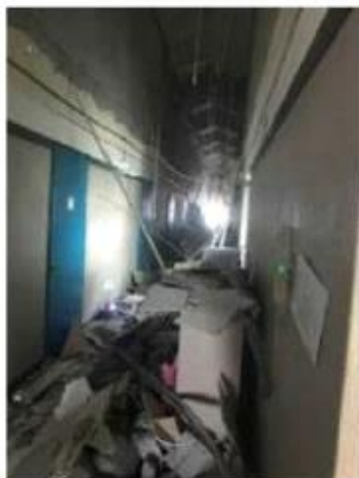
* 천장구조를 탈락에 의한 복도 및 계단실 피난경로 피해(2017. 포항)
