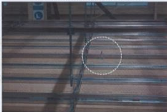
Photo B.13 Minor channel clip 1개소 이탈
